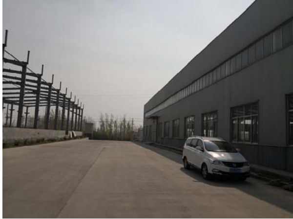
厂房北侧现状照片
