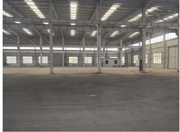
厂房内部现状照片
