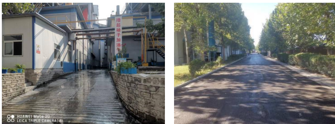
图 3-4 道路、厂区及周边环境情况
