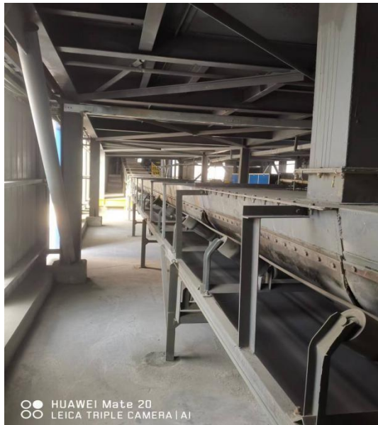
皮带通廊封闭
