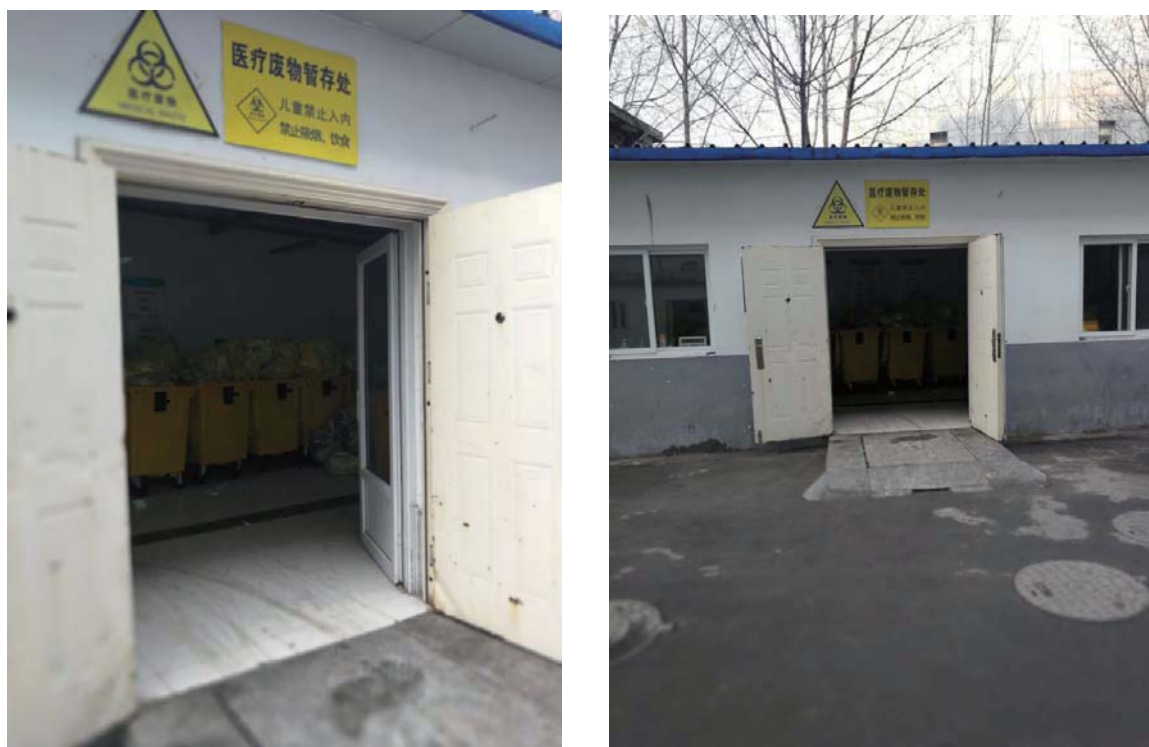
图 医疗废物暂存间
