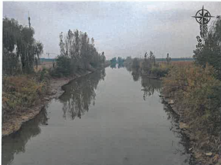
六支排岸坡修复现状
