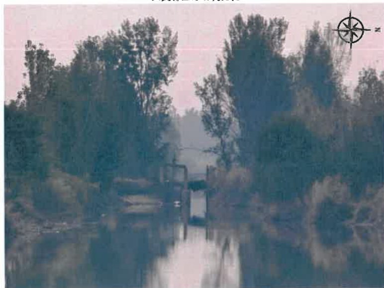
六支排改造水闸现状
